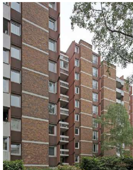
AVANT - Façades sur cour © IMAGE CONTEMPORAINE
