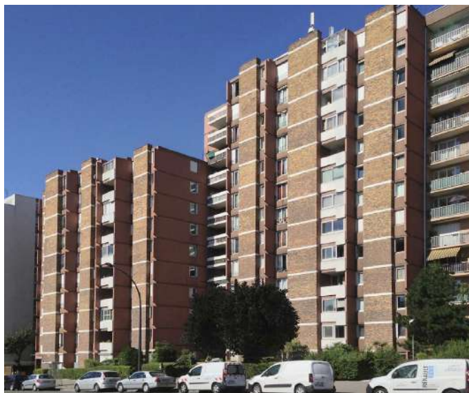
APRÈS - Façades sur cour © JACOTEY VOYATZIS ARCHITECTES ASSOCIES
