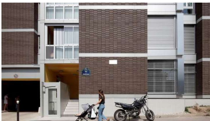
APRÈS - Façades sur rue - © OLIVIER WOGENSCKY
