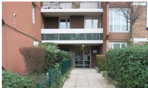
AVANT - Entrée immeuble © JACOTEY-VOYATZIS ARCHITECTES ASSOCIÉS
