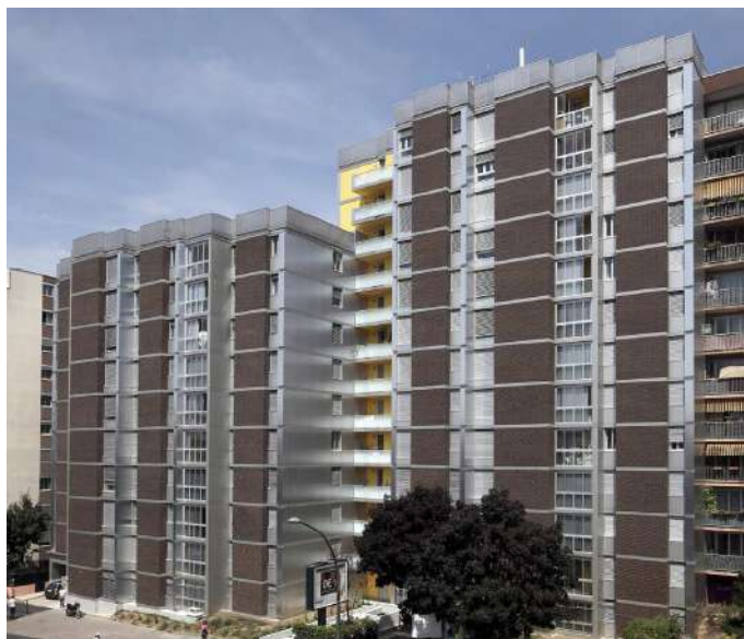
APRÈS - Façades sur rue de Courcelles © OLIVIER WOGENSCKY
