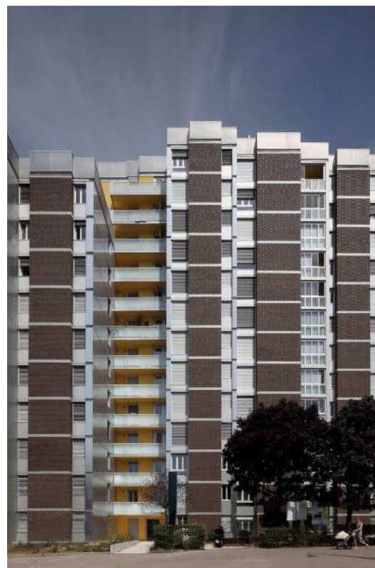
APRÈS - Façades sur rue - © OLIVIER WOGENSCKY
