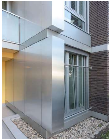
APRÈS - Façades sur rue © IMAGE CONTEMPORAINE
