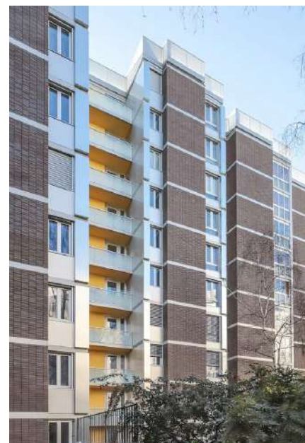
APRÈS - Façades sur cour © IMAGE CONTEMPORAINE
