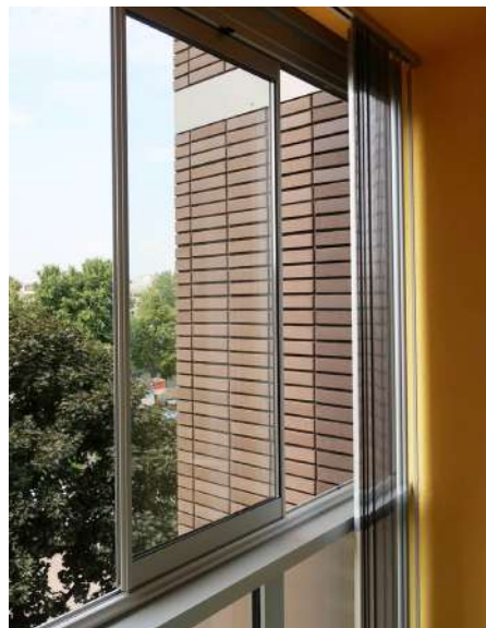
APRÈS - Détail d'intérieur, loggia © JACOTEY-VOYATZIS ARCHITECTE ASSOCIES
