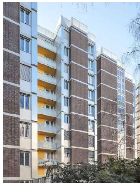
APRÈS - Façades sur cour © IMAGE CONTEMPORAINE
